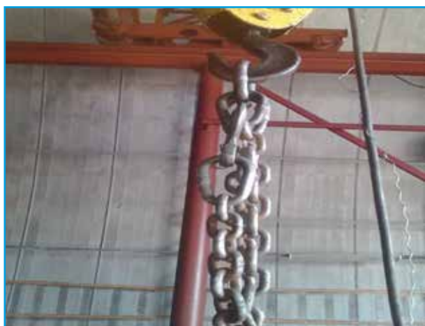
На крюке кран-балки отсутствует предохранительный замок
